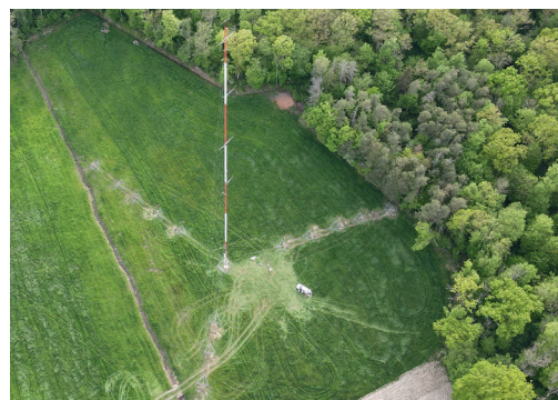
Mât de mesure à Damas-aux-Bois © H2air
